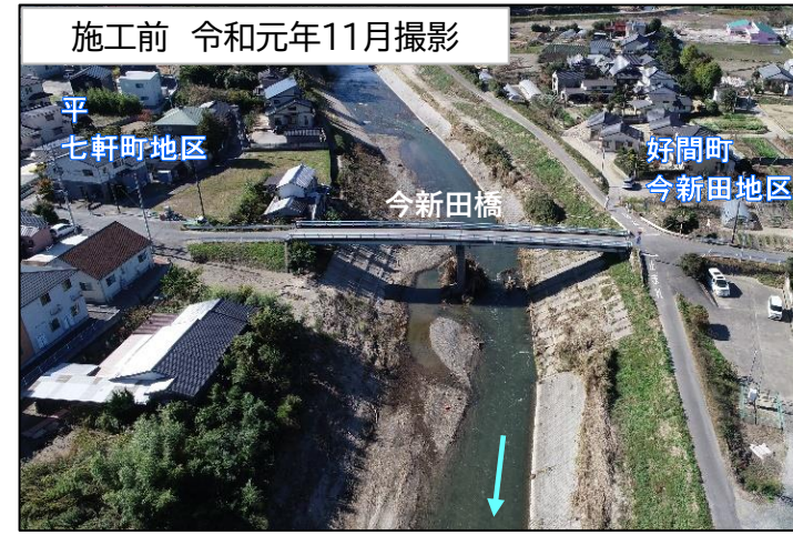
②好間川2工区 平七軒町地内
