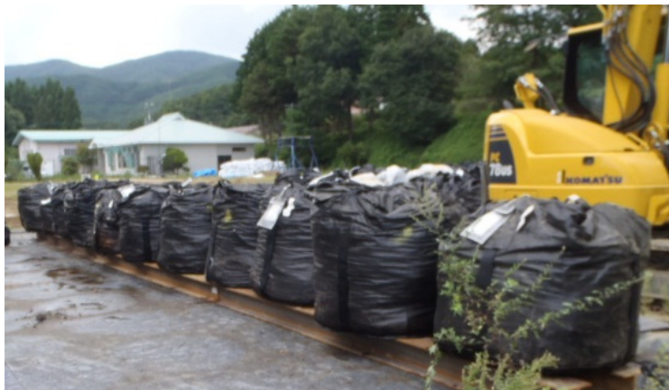
図 3-10 水切り架台の設置状況の例
