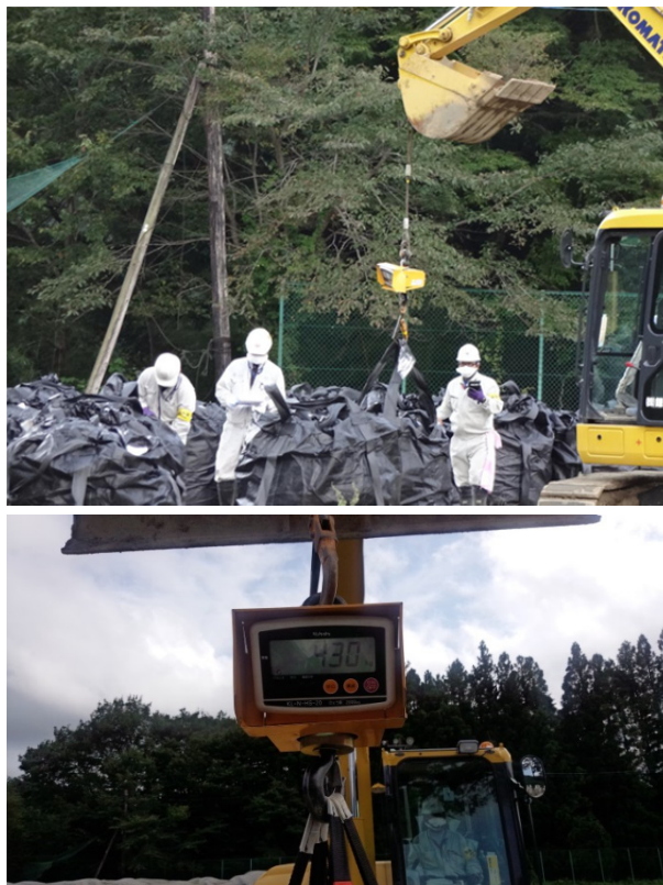
図 3-11 重量測定状況
