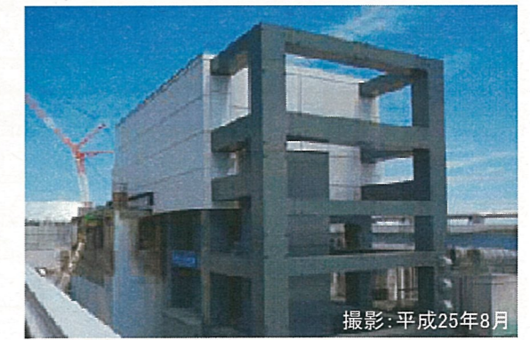
燃料取出カバー設置後
