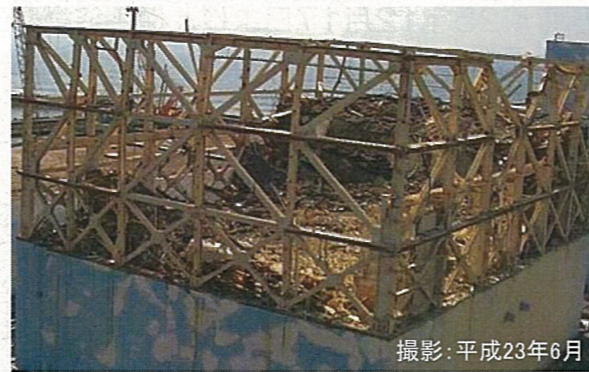
建屋カバー設置前の状況
