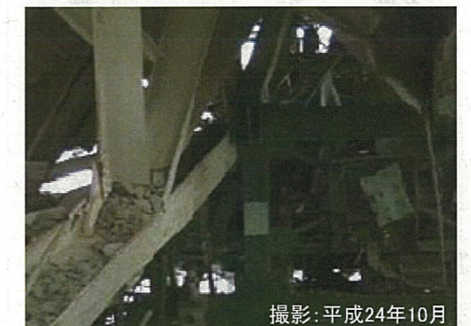
建屋カバー内の状況
