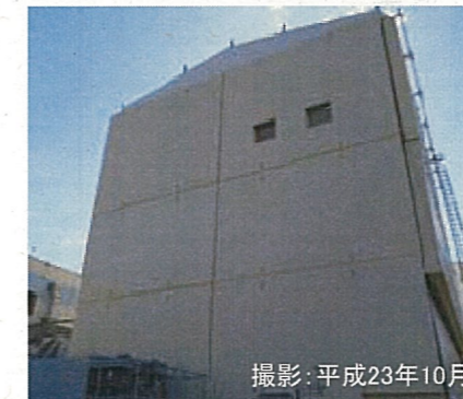
建屋カバーの設置状況
