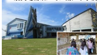
震災遺構浪江町立請戸小学校
