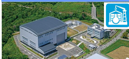
JAEC福島遠隔技術開発センター 廃炉作業の実証実験(※1)
