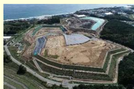
中間貯蔵施設（大熊⑤工区）の様子
