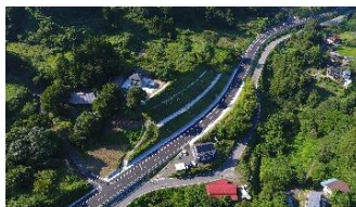
国道349号 (大綱木工区) 2023年3月21日 完成
