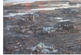
津波被害：浪江町
