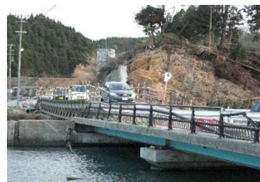
写真 碎石での応急措置
