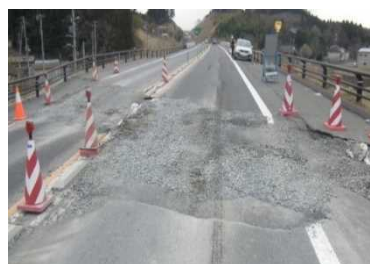
写真 碎石での応急措置
