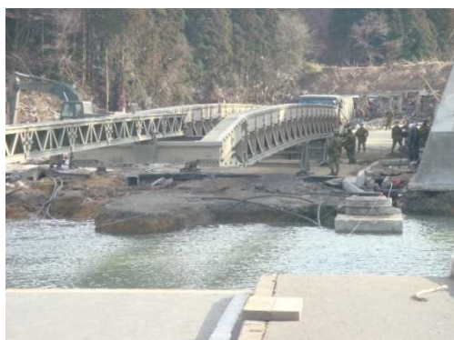
写真 応急仮設橋による通行確保
