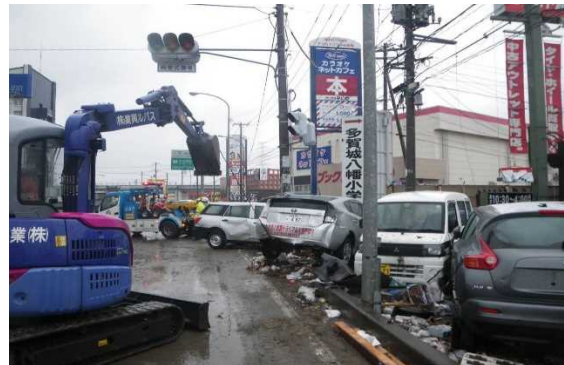
写真 災害時の撤去作業状況
