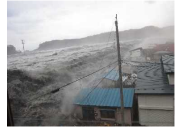
写真 被災状況
