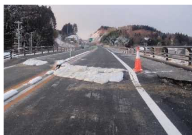
写真 土嚢での応急措置
