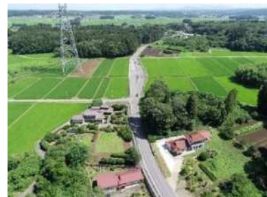
R118 板橋工区 （棚倉町）
