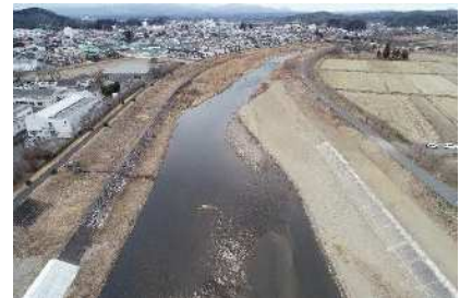
施工状況（阿武隈川）
