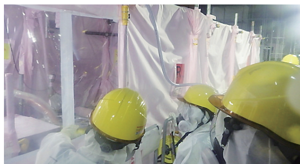
対策（ホース固縛等）の確認状況
