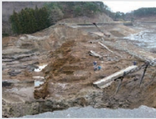
本震により崩壊した灌がい用アースダム 【死者7人、行方不明者1人】（須賀川市長沼）
