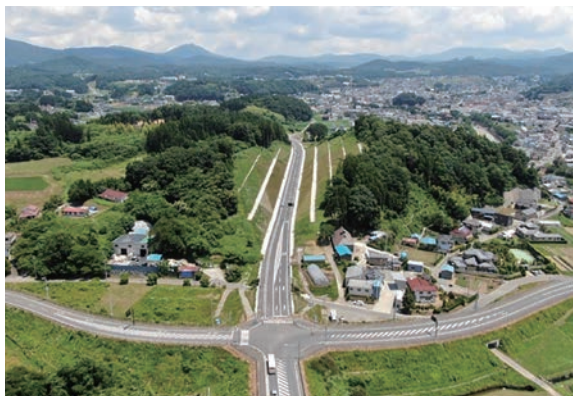
国道288号 船引バイパス
