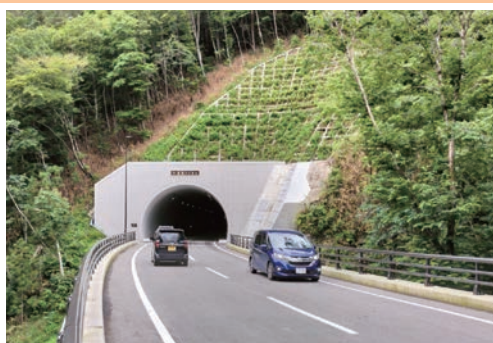
国道288号野上小塚工区(R4.7.16供用)
