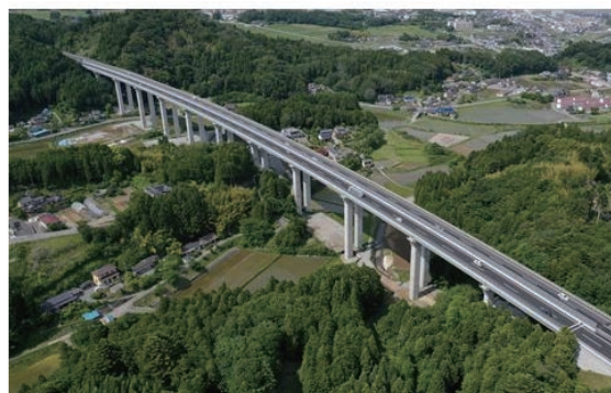
基幹的な道路 （常磐自動車道 折木川橋【広野町】）
