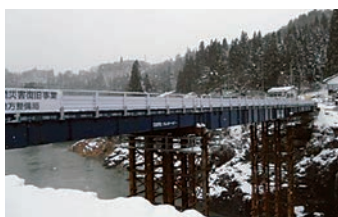
H23.12.20応急復旧完了 (仮橋供用開始)
