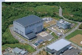
檜葉遠隔技術開発センター
