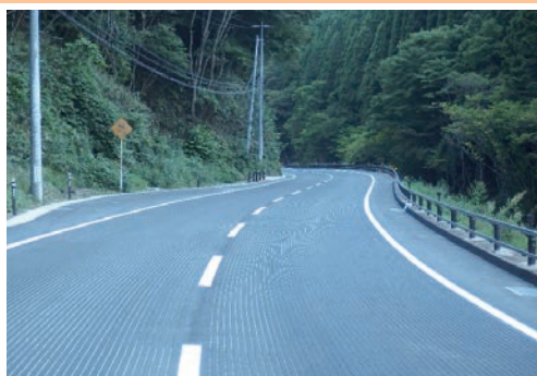
県道小野富岡線五枚沢1工区(H30.9.28供用)
