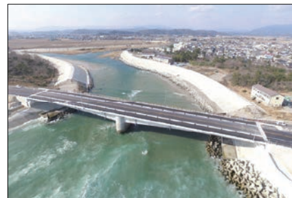
豊間四倉線 東舞子橋工区（いわき市）
