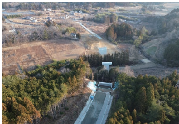
小野富岡線 高津戸工区
