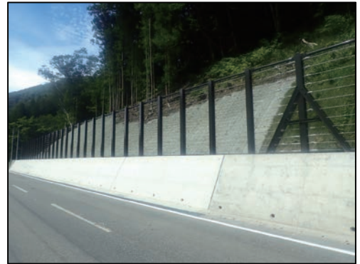
落石防護柵施工箇所 （国道352号 大原工区 南会津町）
