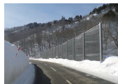
雪崩対策施設設置 (国道352号 南会津町)
