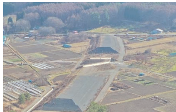
基幹的な道路 （国道121号 下郷田島BP【下郷町、南会津町】）
