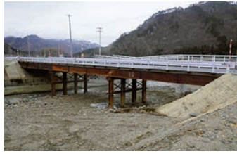
H23.11.11応急復旧完了 (通行止め解除)
