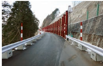
H23.12.22応急復旧完了 (通行止め解除)
