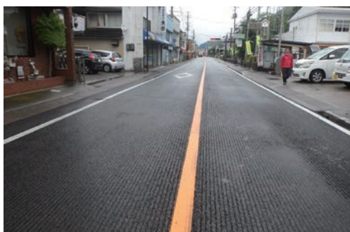
アスファルト舗装【20年設計】 (国道118号 矢祭町)
