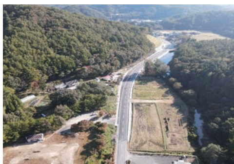
基幹的な道路 （小野富岡線 西ノ内工区【川内村】）
