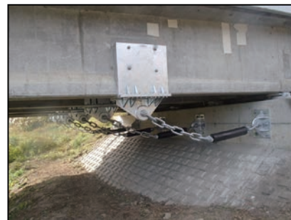
対策実施済の橋梁 (塙大津港線 塙町)
