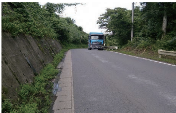
幅員が狭小な観光拠点へのアクセス道路 (山本不動線 棚倉町)
