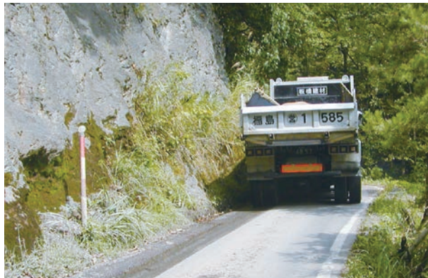
熱塩加納山都西会津線 一ノ俣工区（喜多方市）
