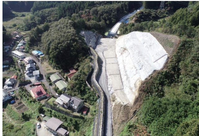
地域連携道路 (いわき石川線 石川BP1工区)
