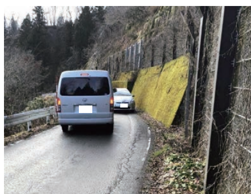
車両のすれ違い困難箇所 (会津若松三島線 三島町)
