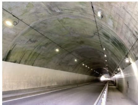
トンネル照明のLED化
