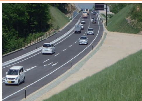
国道288号三春西BP(H25.5.23供用)
