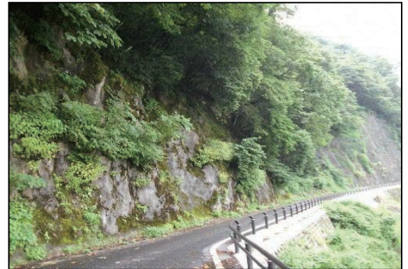
落石対策予定箇所 （国道459号 蟹沢乙工区 西会津町）
