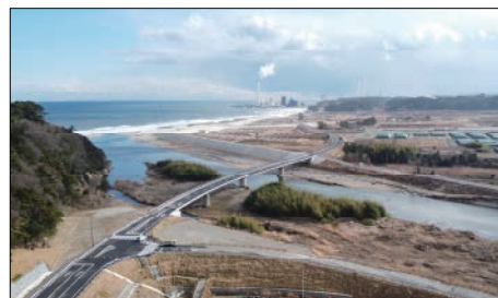
広野小高線 天神工区（檜葉町）
