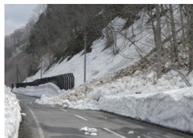
雪崩危険箇所 (国道352号 檜枝岐村)
