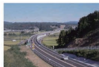
福島空港道路
