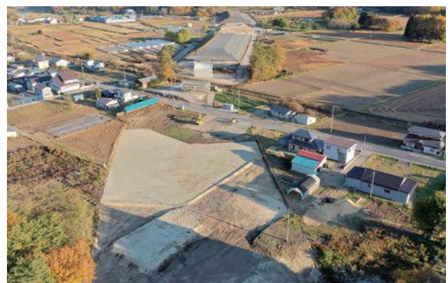
基幹的な道路 （会津縦貫南道路 下郷田島BP【南会津町】）
