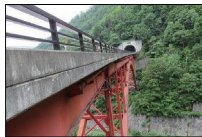
耐震補強予定の橋梁 (国道121号 喜多方市)
