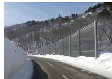
雪崩対策施設設置 (国道352号 南会津町)
