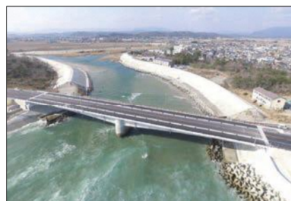
豊間四倉線 東舞子橋工区（いわき市）
