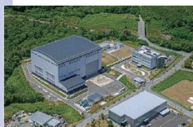
楢葉遠隔技術開発センター
