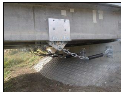
対策実施済の橋梁 (塙大津港線 塙町)
