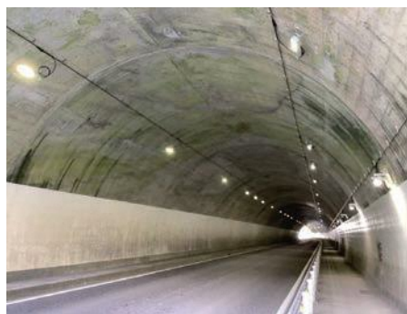
トンネル照明のLED化
