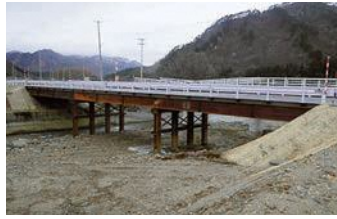
H23.11.11応急復旧完了 (通行止め解除)
