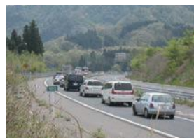
〈阿賀野川SA付近〉
