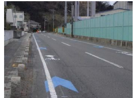
自転車走行空間の整備 (いわき七浜海道 いわき市)
