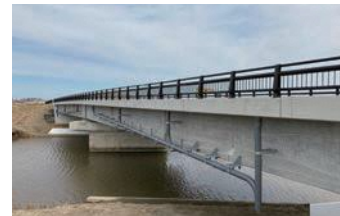
R2.12.25新橋供用
