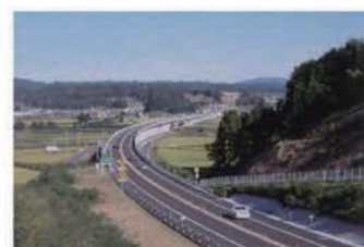
福島空港道路
