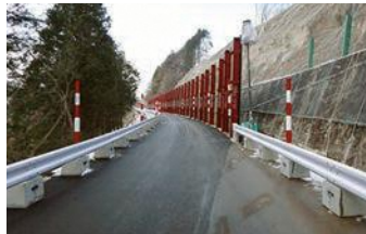
H23.12.22応急復旧完了 (通行止め解除)
