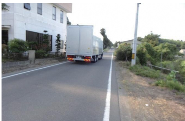
須賀川矢吹線 天開2工区（矢吹町）
