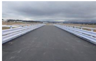
H31.3.29仮橋供用開始
