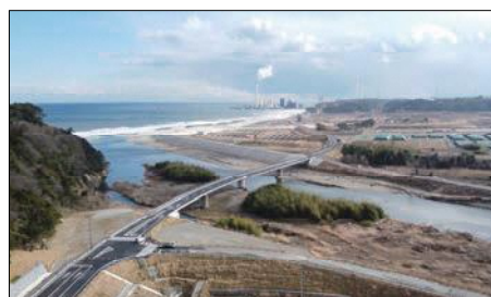
広野小高線 天神工区（楢葉町）
