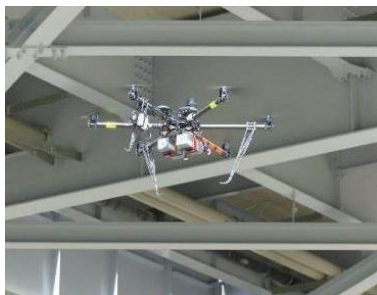
ドローンによる橋梁点検
