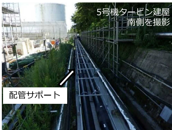
移送配管サポート設置の状況
