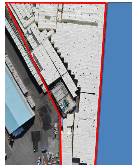
耐候性シートへのリブレース完了 一時保管エリアW1
