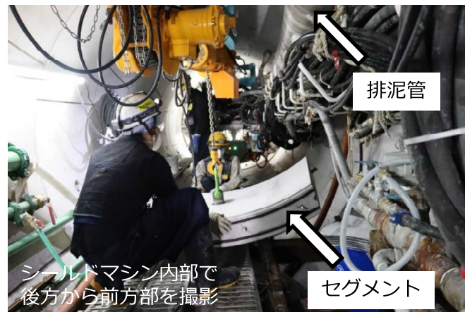
セグメント搬送状況（トンネル内）
