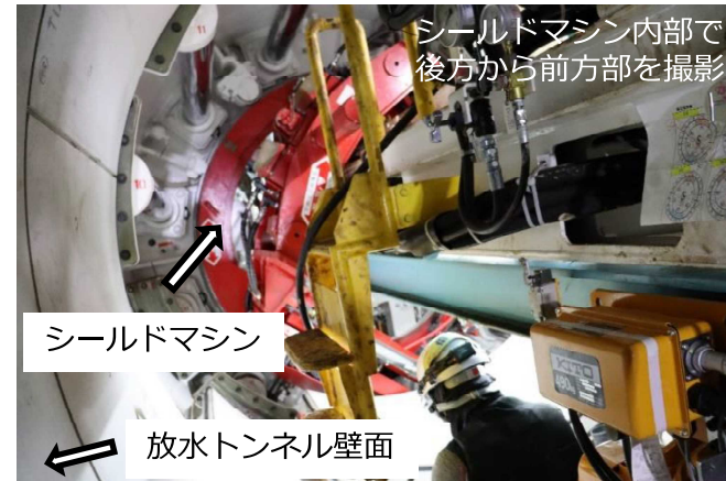
シールドマシン掘進作業の状況
