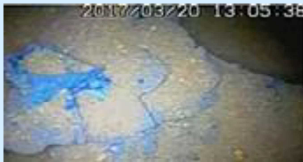
ペDESTAL外側の状況
