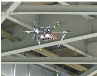
ドローンによる橋梁点検
