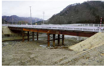
H23.11.11応急復旧完了 (通行止め解除)
