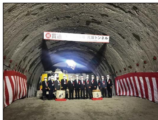
トンネル貫通式 (国道118号 鳳坂工区 天栄村)
