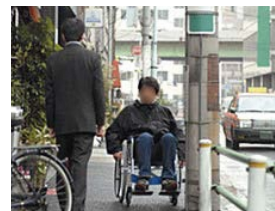
電柱が車いすの通行の妨げになっている歩道（出典：国土交通省）
