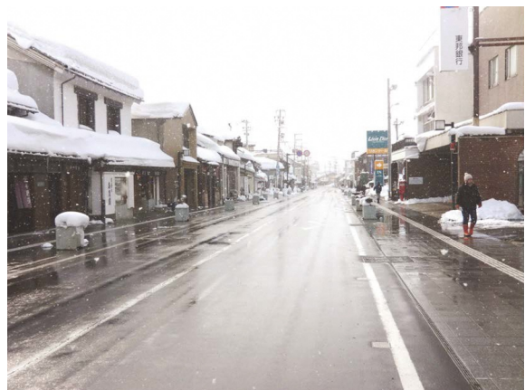
無散水消雪設備 喜多方会津坂下線 三丁目工区（喜多方市）
