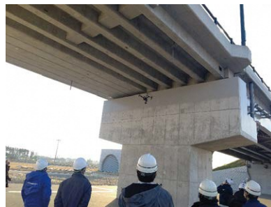
点検支援技術講習会の状況
