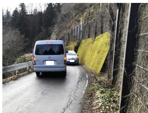
車両のすれ違いが困難な箇所 (会津若松三島線 三島町)
