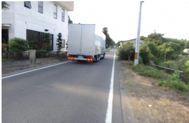
須賀川矢吹線 天関工区（矢吹町）
