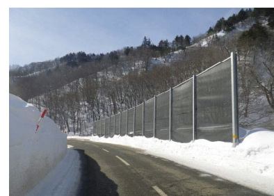
雪崩対策施設設置 (国道352号 南会津町)
