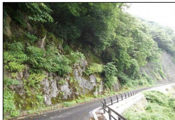
落石対策予定箇所 (国道459号 蟹沢乙工区 西会津町)
