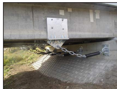
対策実施墨の橋梁 (塙大津港線 塙町)
