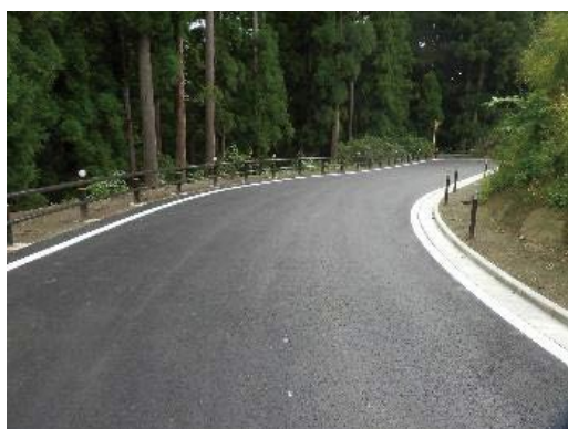
車両のすれ違いが困難な箇所の解消 (藤小椿線 柳津町)
