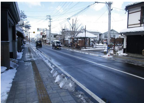
無散水消雪設備 国道252号 七日町工区（下の区） （会津若松市）
