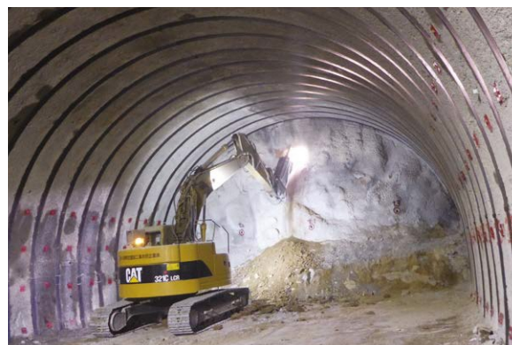
国道114号 山木屋1工区
