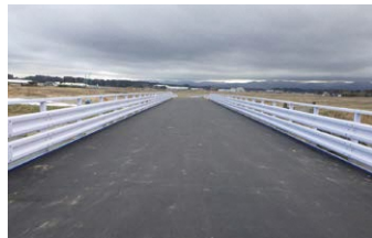
H31.3.29仮橋供用開始
