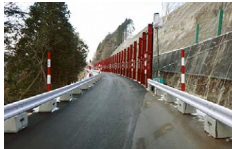
H23.12.22応急復旧完了 (通行止め解除)
