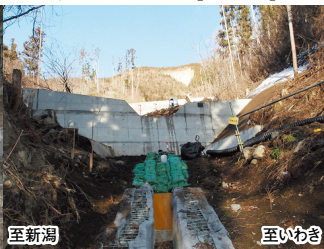
⑤ダム施工完了【県施工】
