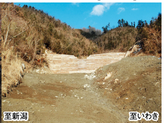
⑥ダム施工完了【国施工】
