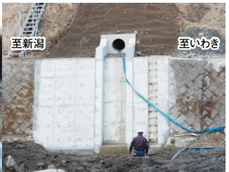
③排水工施工完了
