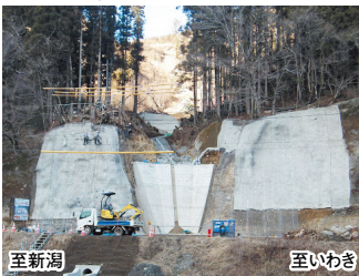
④擁壁工施工完了
