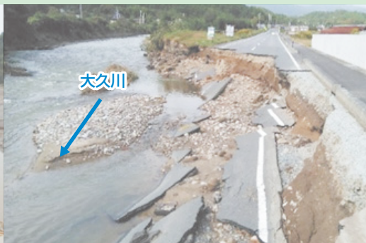
道路の洗掘(県道折木筒木原久之浜線:いわき市)
