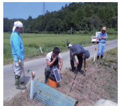
イノシシ被害対策の電気柵設置
