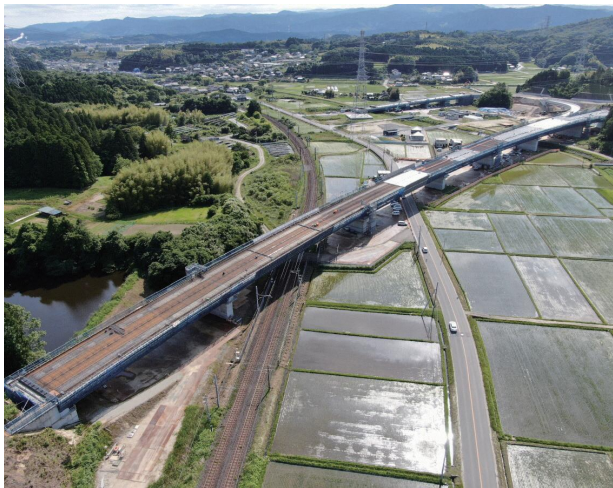
ふくしま復興再生道路（小名浜道路）
