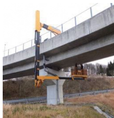
橋梁点検(あぶくま高原道路)
