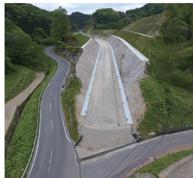
ふくしま復興再生道路(国道349号)
