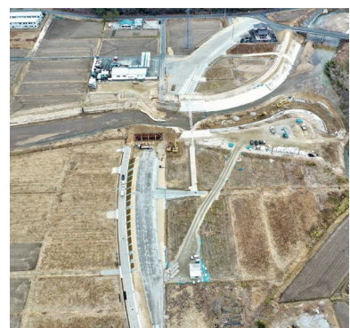
県道小野富岡線の整備状況
