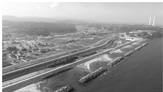
浅見川地区（広野町）の復旧状況
