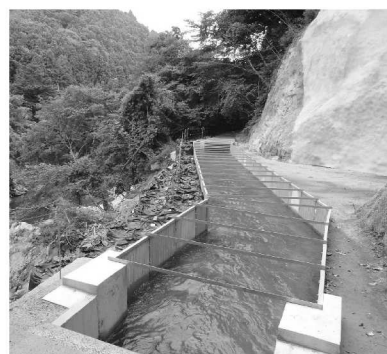
用水路応急復旧工事（相馬市）
