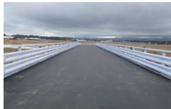
H31.3.29仮橋供用開始
