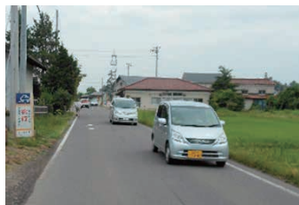
梁川霊山線 薬師前工区 (伊達市)
