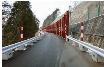
H23.12.22応急復旧完了 (通行止め解除)
