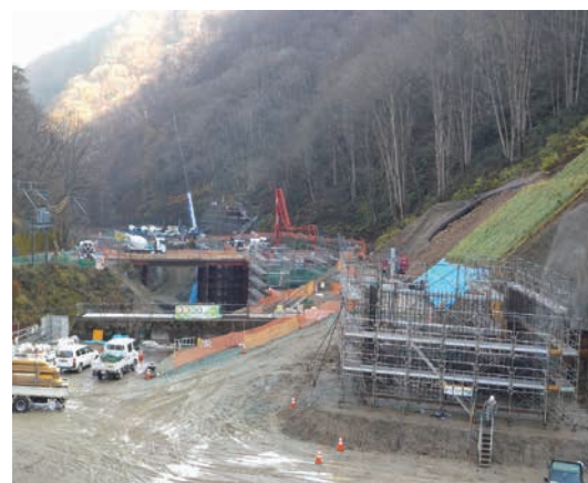
施工状況（国道401号）
