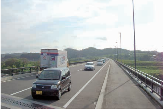
国道288号（富久山バイパス）の整備状況
