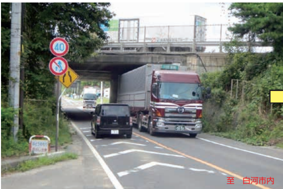
国道294号（豊地工区）の現道状況
