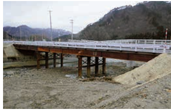
H23.11.11応急復旧完了 (通行止め解除)
