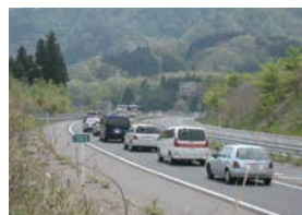
〈阿賀野川SA付近〉
