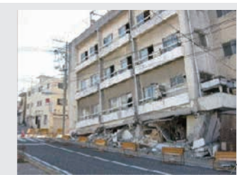
県道沿線の建物倒壊（郡山市麓山地内）
