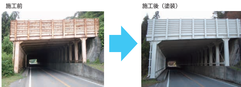
国道252号 本名スノーシェッド（金山町）
