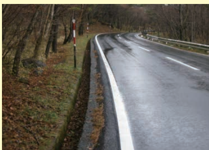
路肩がせまく走りづらい道路
