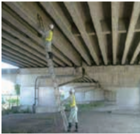
橋梁の定期点検実施状況
