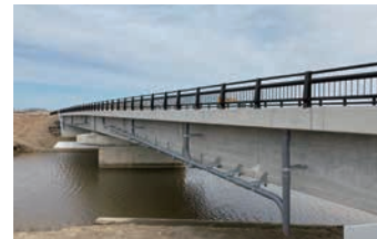
R2.12.25新橋供用
