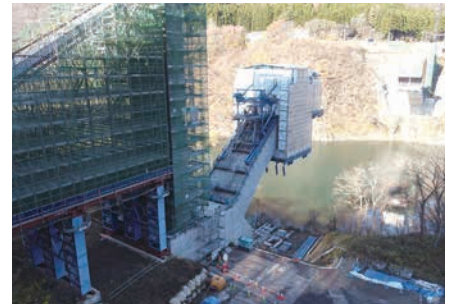
国道118号小沼崎バイパス (下郷大橋)
