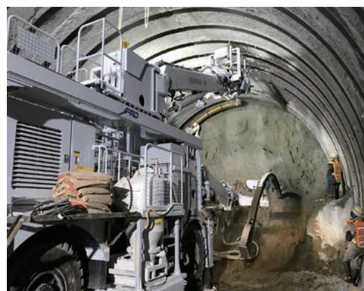
施工状況（国道118号）
