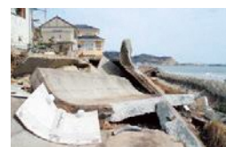
海岸：いわき市 Levee: Iwaki City
