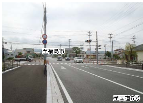
国道114号浪江拡幅1工区(浪江町) 平成27年9月29日開通
