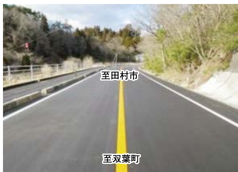
国道288号野上山神工区(大熊町) 平成28年3月29日開通
