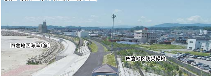
復旧・復興工事の状況(四倉地区)
