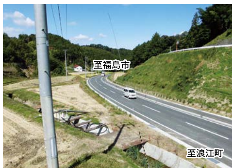
国道114号小綱木バイパス(川俣町) 平成27年6月28日開通
