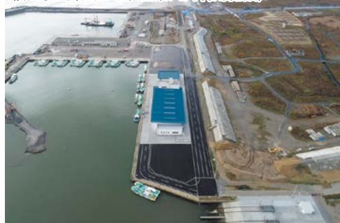
復旧状況(浪江町水産業共同利用施設)
