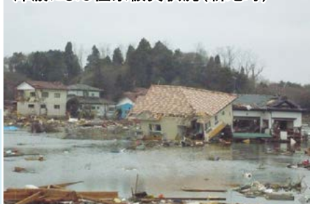
津波による住家被災状況(新地町)
