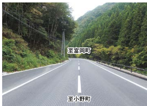
県道小野富岡線五枚沢1工区(川内村) 平成30年9月28日開通
