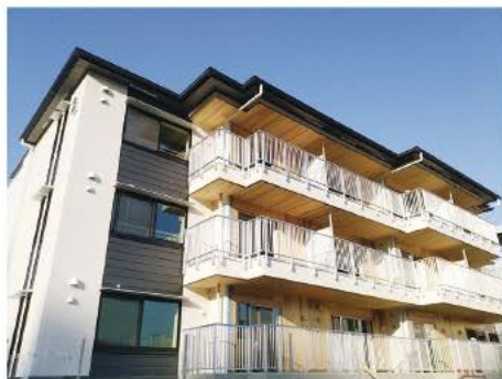
【写真 7-10】 CLT パネル工法により建設された復興公営住宅
