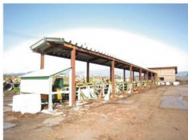
【写真 7-1】 一般材の取り扱い強化をきっかけに選別機を導入
