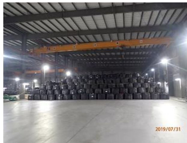
焼却灰の保管状況の確認
