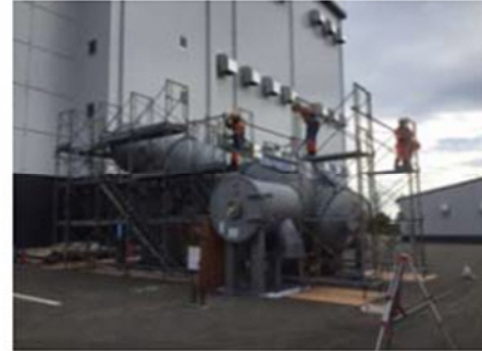
ベント管1/1スケール試験
