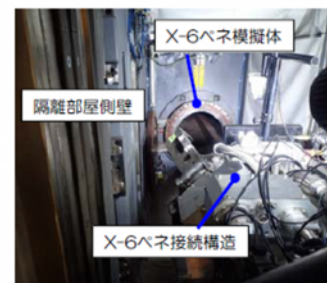
隔離部屋内作業(X-6ペネ近傍)組合せ試験の状況
