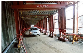
H23.10.17 応急復旧完了 (通行止め解除)
