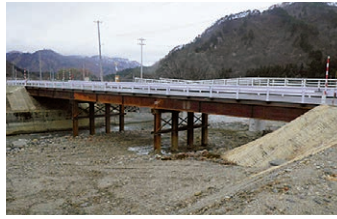
H23.11.11 応急復旧完了 (通行止め解除)
