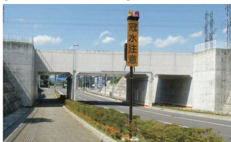
白河羽鳥線「昭和町ボックス」(白河市)
