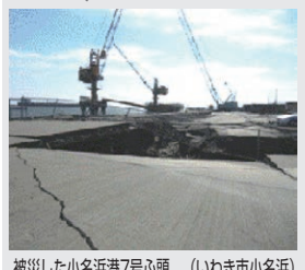
被災した小名浜港7号3頭（いわき市小名浜）
