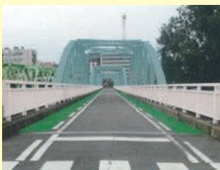
補修時に地域の意見を聞きながら橋梁の防護柵などを塗り替えて景観の向上を図る
