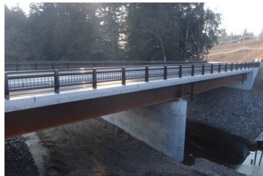
整備後（25t 車両対応）
