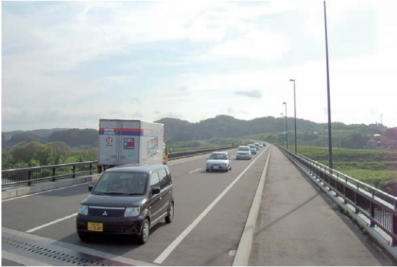
国道288号（富久山バイパス）の整備状況
