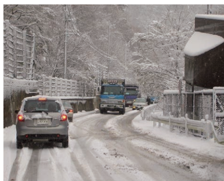
冬期交通支障状況 (国道118号)
