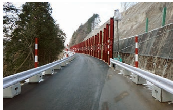
H23.12.22 応急復旧完了 (通行止め解除)
