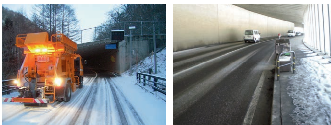
凍結抑制剤散布車の散布状況
