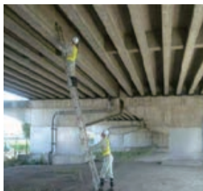
橋梁の定期点検実施状況
