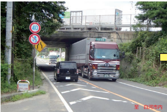
国道294号（豊地工区）の現道状況
