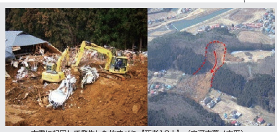
本震に起因して発生した地すべり【死者13人】（白河市葉ノ木平）
