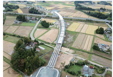
国道115号相馬福島道路（仮）今田高架橋
