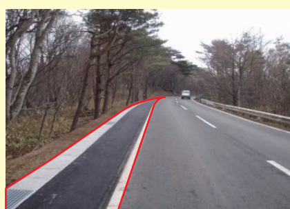
側溝の位置を工夫して路肩を広げた状況
