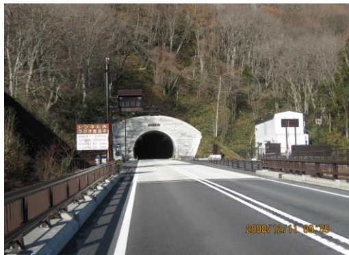
甲子トンネル西郷坑口
