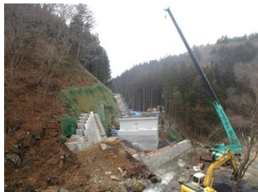
国道289号 渡瀬工区 (鮫川村)
