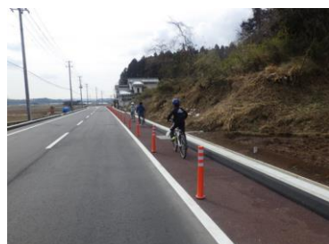
須賀川矢吹線 天開工区 (矢吹町)
