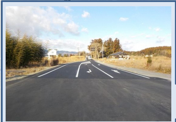
改良工事後の道路の様子(県道251号線)
