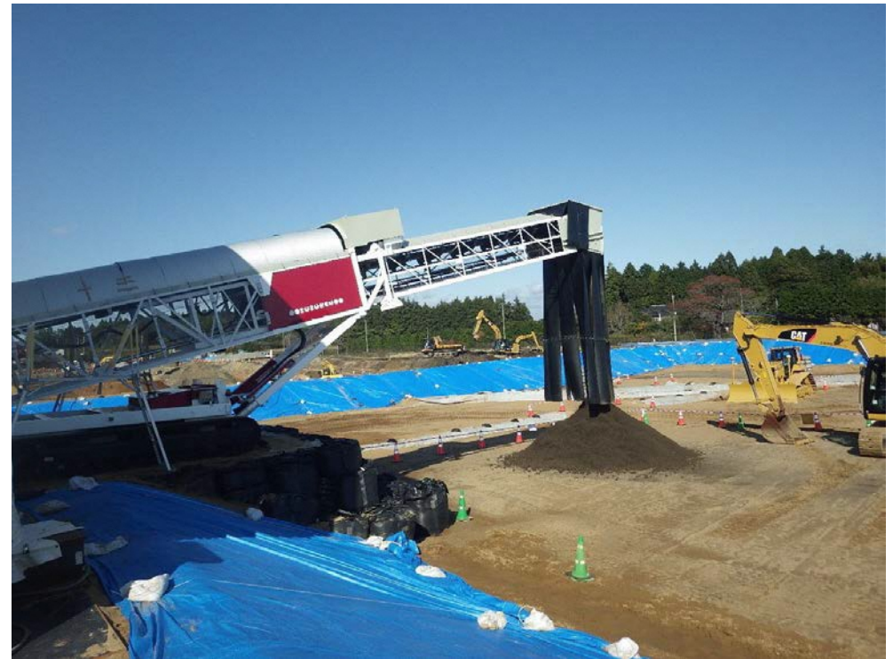
土壌貯蔵施設における貯蔵作業状況
