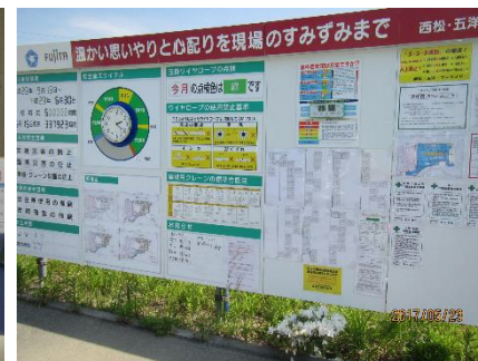
施工体制他安全表示確認
