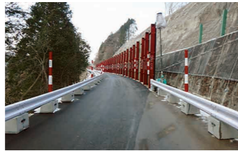
H23.12.22応急復旧完了 (通行止め解除)
