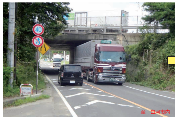
国道294号 (豊地工区) の現状状況
