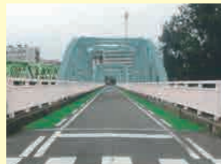
補修時に地域の意見を聞きながら橋梁の防護柵などを塗り替えて景観の向上を図る
