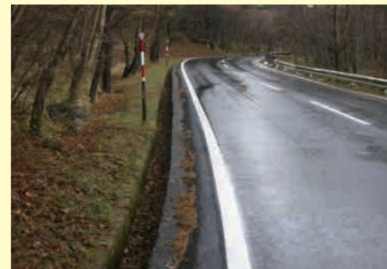
路肩がせまく走りづらい道路
