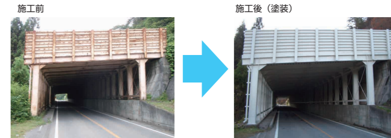
国道252号 本名スノーシェッド（金山町）
