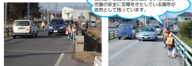
郡山矢吹線【郡山市片平町区内】
