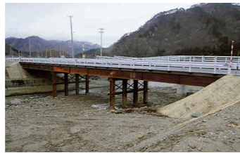
H23.11.11応急復旧完了 (通行止め解除)
