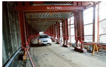
H23.10.17応急復旧完了 (通行止め解除)
