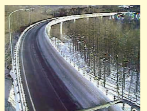
国道115号 土湯峠(横向大橋)
