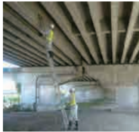
橋梁の定期点検実施状況
