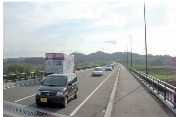
国道288号 (富久山バイパス) の整備状況
