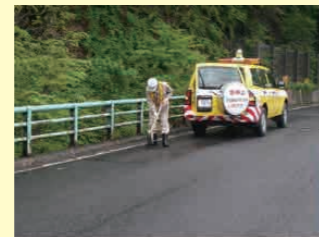
パトロールで発見した損傷箇所を応急処置
