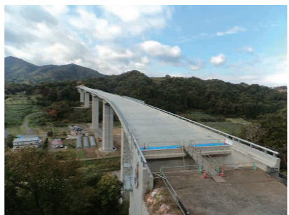
国道115号相馬福島道路（仮）月館高架橋
