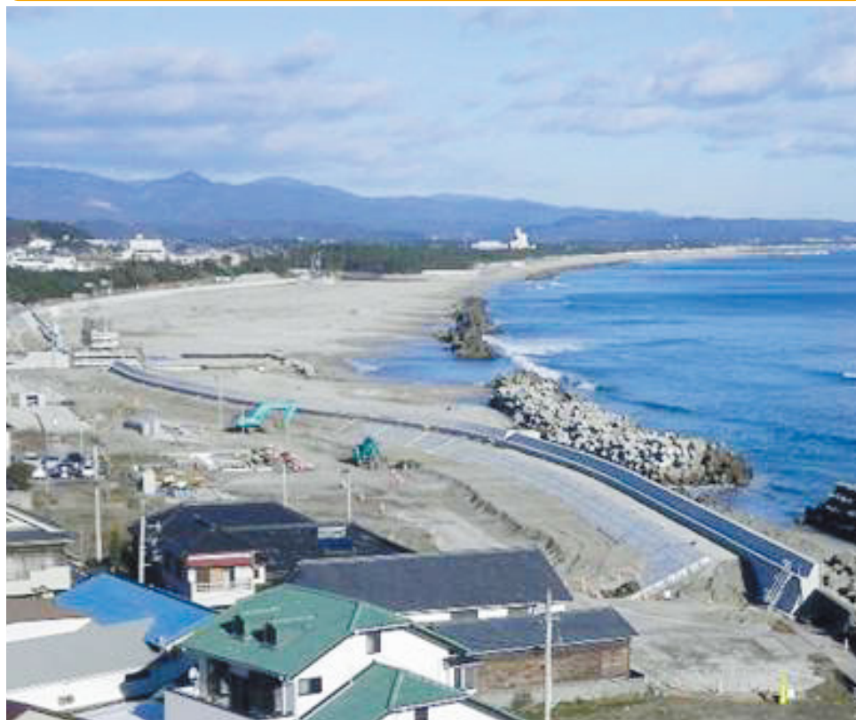
復旧・復興工事の状況 (沼ノ内地区海岸全景)
