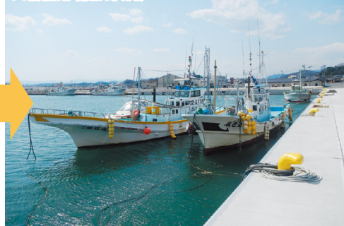
四倉漁港(復旧状況)
