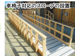
車椅子対応のスロープの設置
