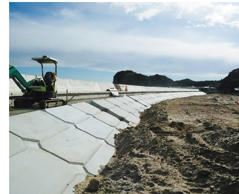
復旧・復興工事の状況 沼ノ内地区海岸
