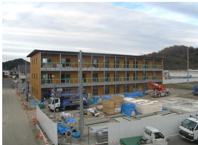
屋根・建具工事
