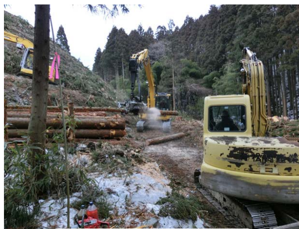
造材作業(プロセッサー)
