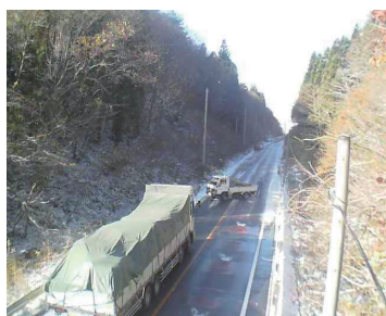
冬季交通支障状況(原町川俣線)
