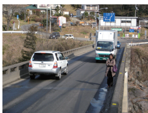
霊山松川線 逢隈橋 (福島市)
