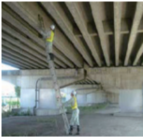
橋梁の定期点検実施状況
