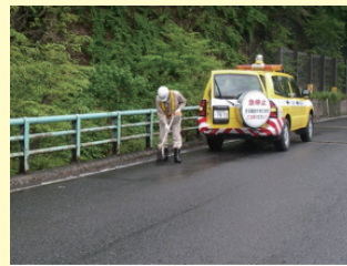
パトロールで発見した損傷箇所を応急処置
