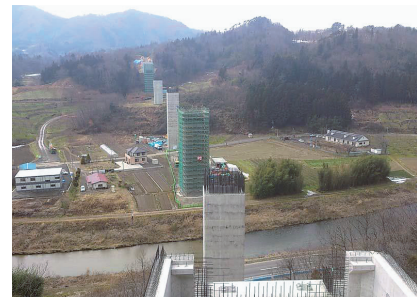
国道115号相馬福島道路((仮)月館高架橋)
