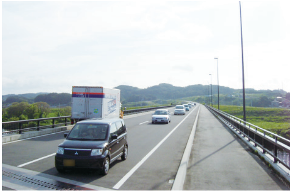
国道288号（富久山バイパス）の整備状況
