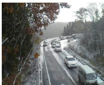
冬季交通支障状況(原町川俣線)
