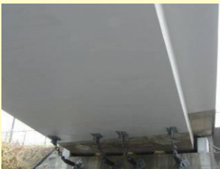
計画的な橋梁補修により長寿命化を図る
