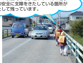
鹿島日下石線【南相馬市鹿島地内】
