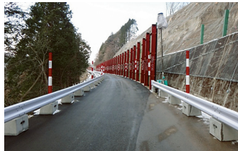
H23.12.22応急復旧完了 (通行止め解除)
