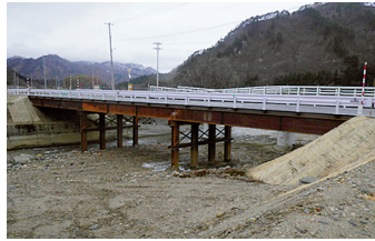
H23.11.11応急復旧完了 (通行止め解除)
