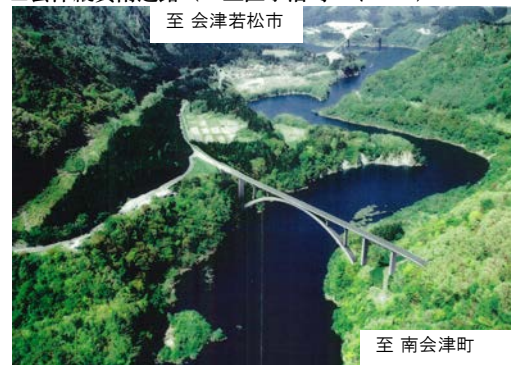
■会津縦貫南道路（4工区小沼崎バイパス）
