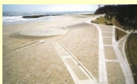
緩傾斜堤防の整備 南相馬市北泉大磯海岸
