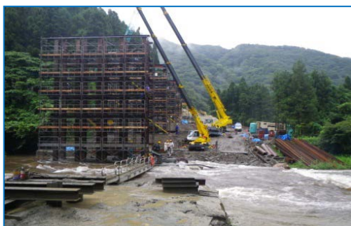
1号仮橋工施工状況 (平成23年7月30日出水時)
