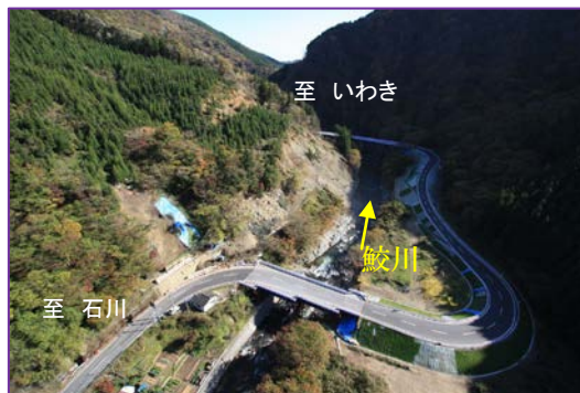
仮道供用開始(平成23年9月20日)
