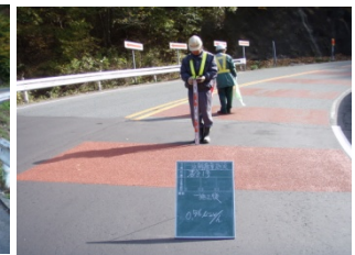
薄層カラー舗装骨材散布
