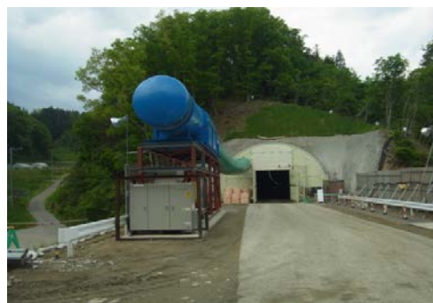
■霊山道路の整備状況（七ッ窪トンネル）
