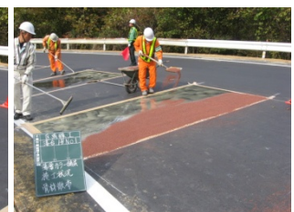
薄層カラー舗装骨材散布
