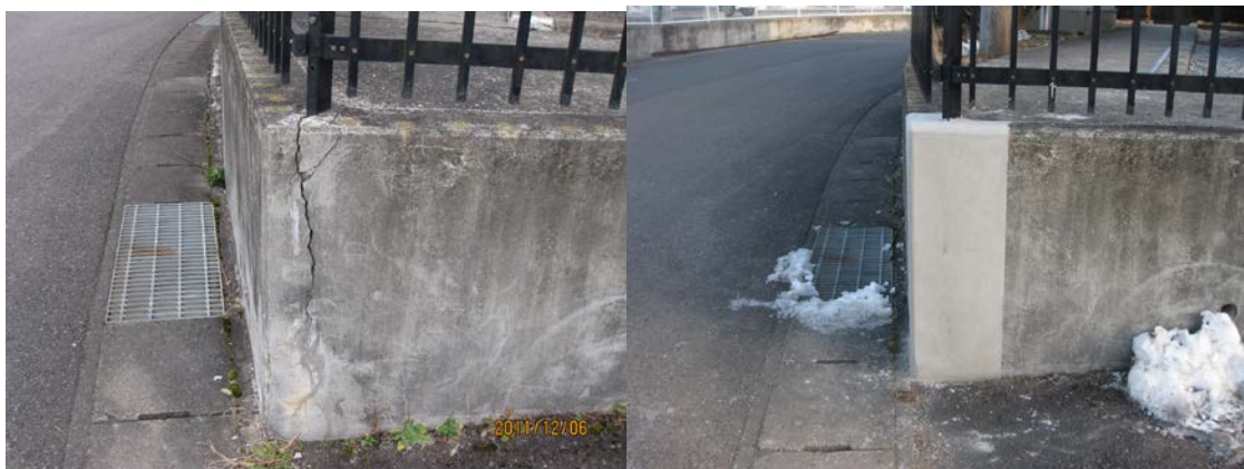
県営真舟団地 施工前 施工後
