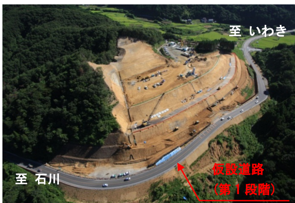
アンカー工着手 (平成 24 年 8 月撮影)
