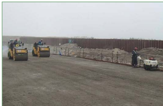
CSG転圧状況（4t振動ローラー）
