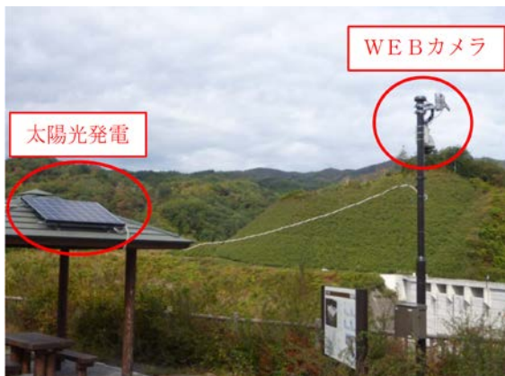
■WEBカメラの設置状況 (携帯電話によるデータ送信)
