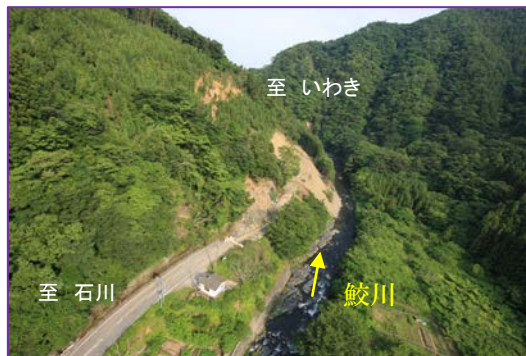
仮道工施工前(平成23年6月13日)
