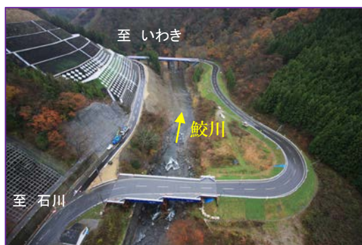
本線再開通(平成24年12月14日)
