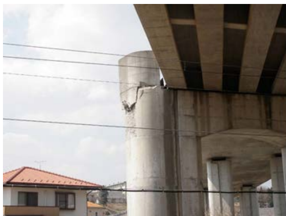
植田跨線橋【日立いわき線：いわき市植田地内】
