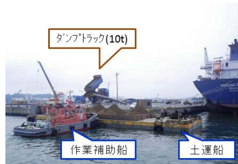
小名浜港への残土運搬状況
