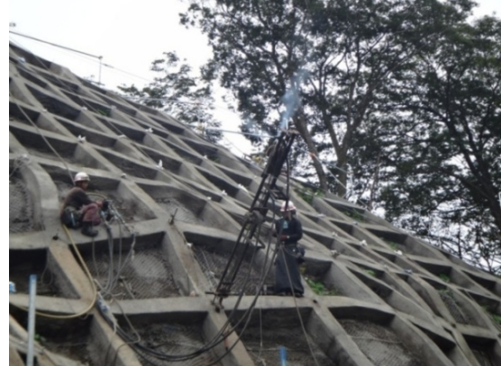
写真 1: スタンドドライブ工法
