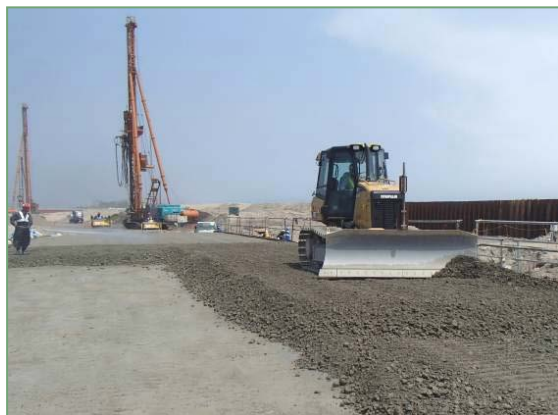
CSG敷均し状況（7tブル）
