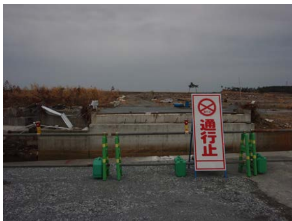
津波により流失した上立切橋（南相馬市方面を望む）
