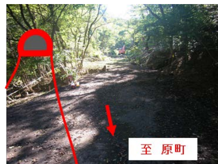
除染後（枝打ち、堆積物除去）工事着手
