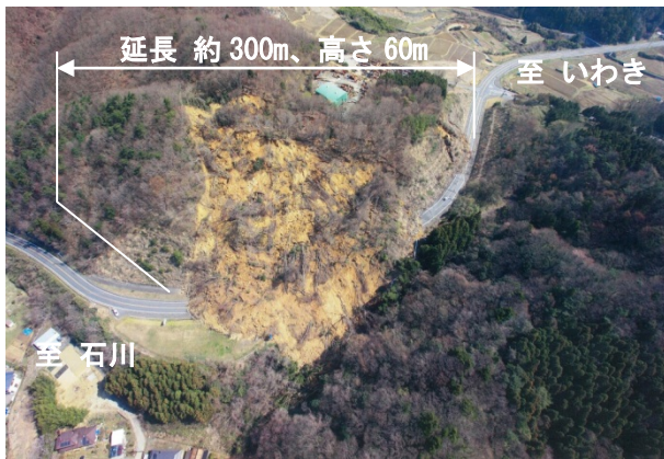
被災状況 (平成 23 年 4 月撮影)
