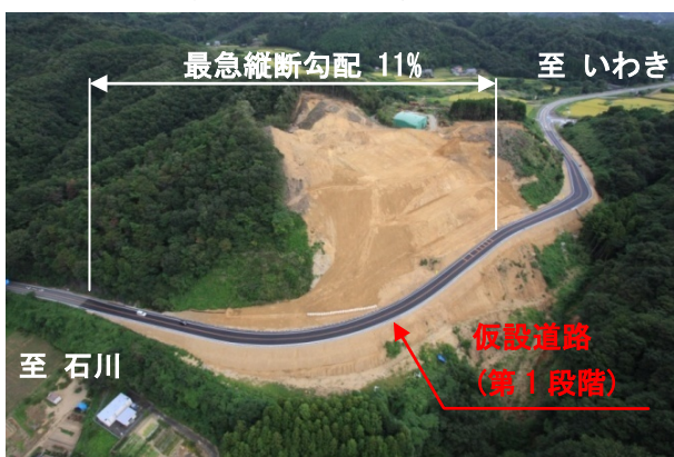
仮設道路完了 (平成 23 年 8 月撮影)
