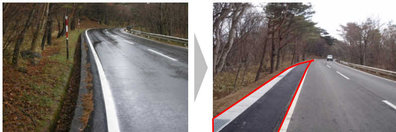
路肩拡幅による走行性改善
