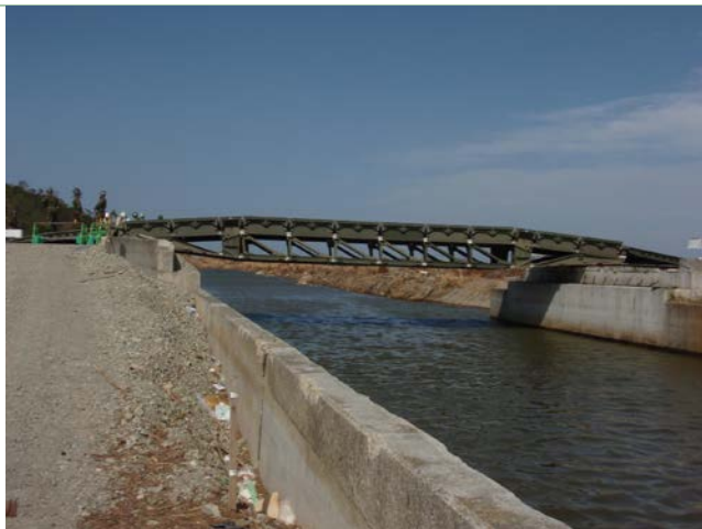
完成した上立切橋仮設橋（河口側を望む）
