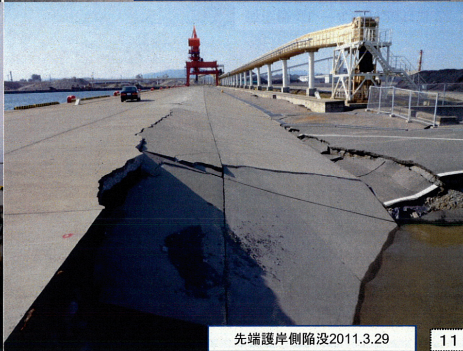
先端護岸の滑動(最大4m以上)2011.4.11
