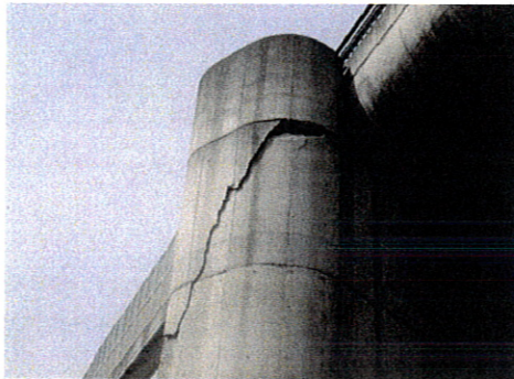
〔道路〕 橋脚損傷 植田跨線橋
