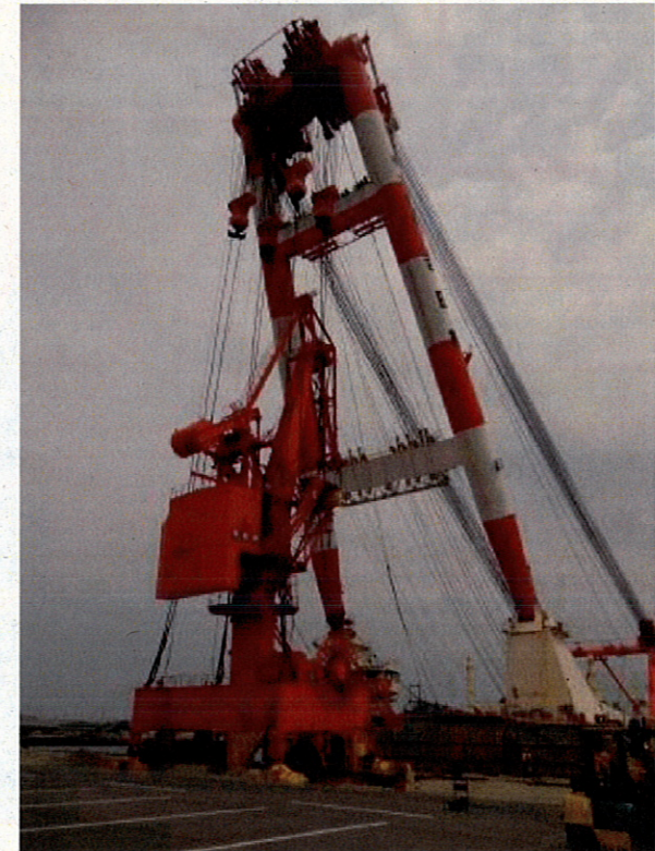
大剣埠頭 多目的クレーン移設状況 (5月17日撮影)
