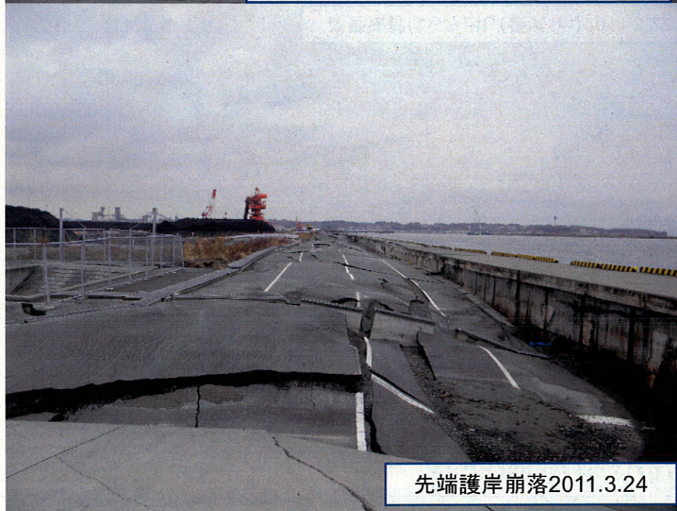
岸壁背後の沈下(最大75cm)2011.3.22
