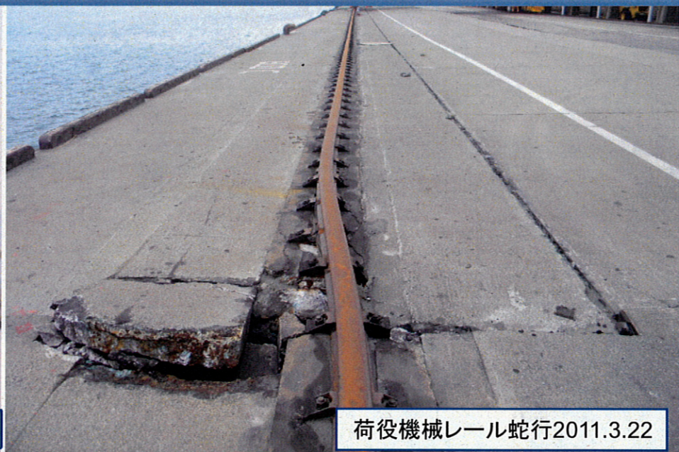
岸壁法線はらみ出し(最大1m)2011.3.22
