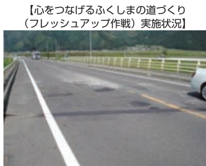
舗装と高欄を補修し機能向上を図るとともに景観の向上を図りました(国道115号 長瀬川橋)
