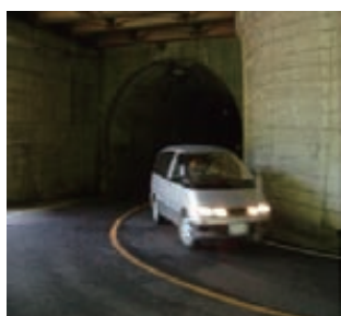
大型車すれ違い困難状況 (国道252号)
