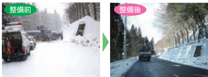
雪を融かすことができる道路 (無散水消雪施設) 国道118号 (鳳坂峠) 天栄村
