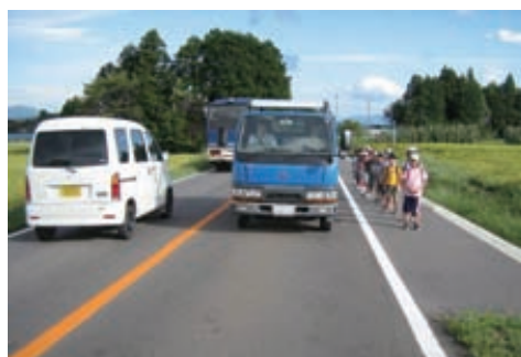
幅広路肩による歩行空間確保事例(本宮土湯温泉線)
