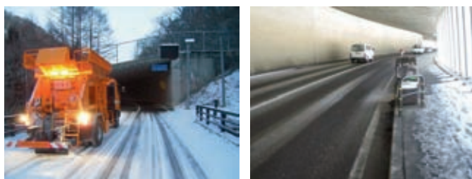
凍結抑制剤散布車の散布状況
