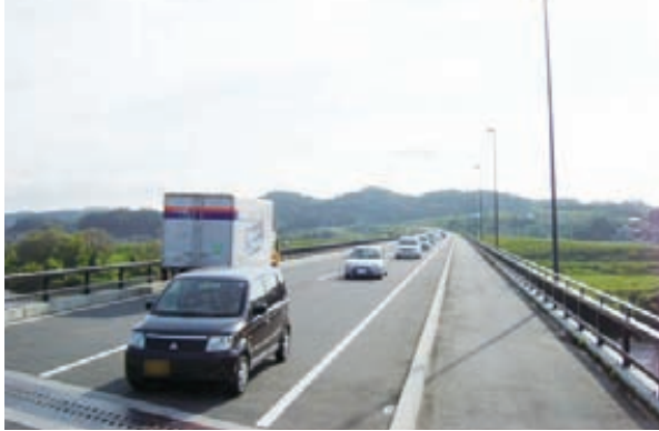
国道288号（富久山バイパス）の整備状況
