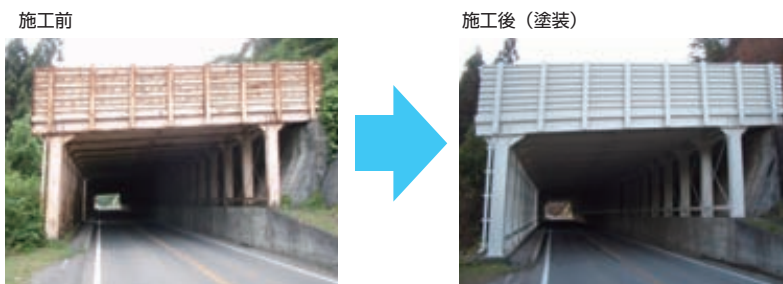
国道252号 本名スノーシェッド（金山町）
