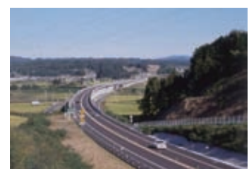
福島空港道路
