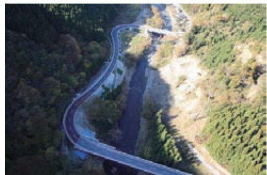
応急復旧（仮道）により交通を確保
