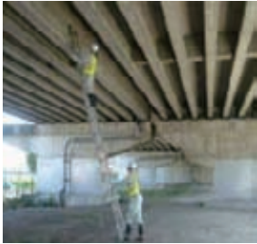
橋梁の定期点検実施状況
