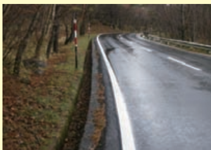
路肩がせまく走りづらい道路
