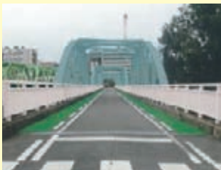
補修時に地域の意見を聞きながら橋梁の防護柵などを塗り替えて景観の向上を図る
