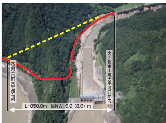
国道252号 (滝バイパス・金山町) 整備計画
