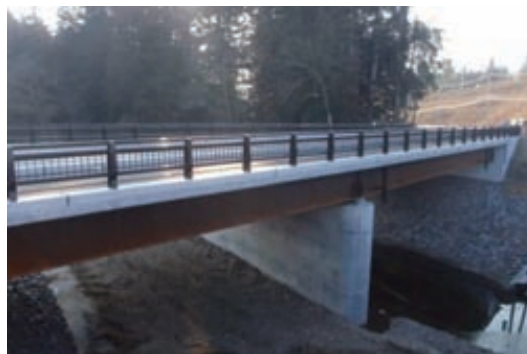
整備後（25t 車両対応）
