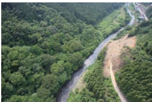
地震により道路脇山腹が崩落（いわき市）
