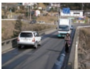
霊山松川線 逢隈橋 (福島市)
